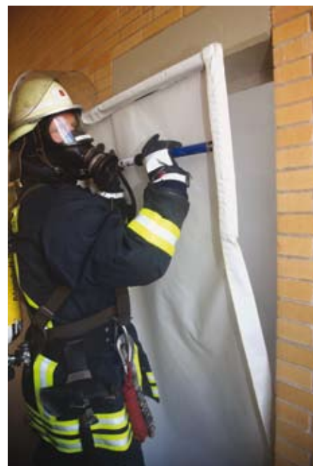
In einer Übung demonstrierte die Aschaffener Feuerwehr, wie die Rauchverschlüsse mit wenigen Handgriffen montiert werden können.
